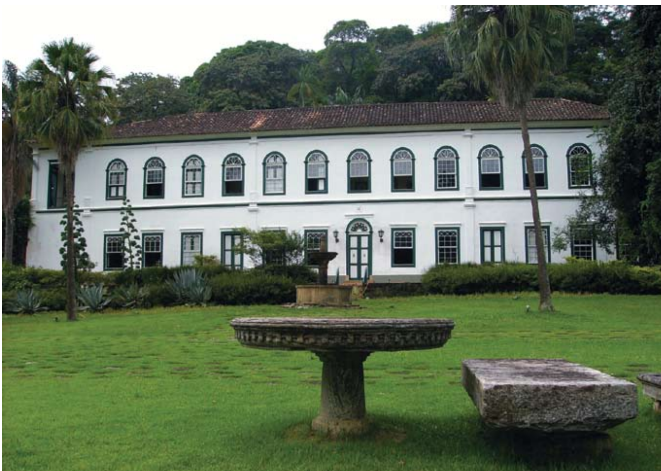
vista da fachada lateral
